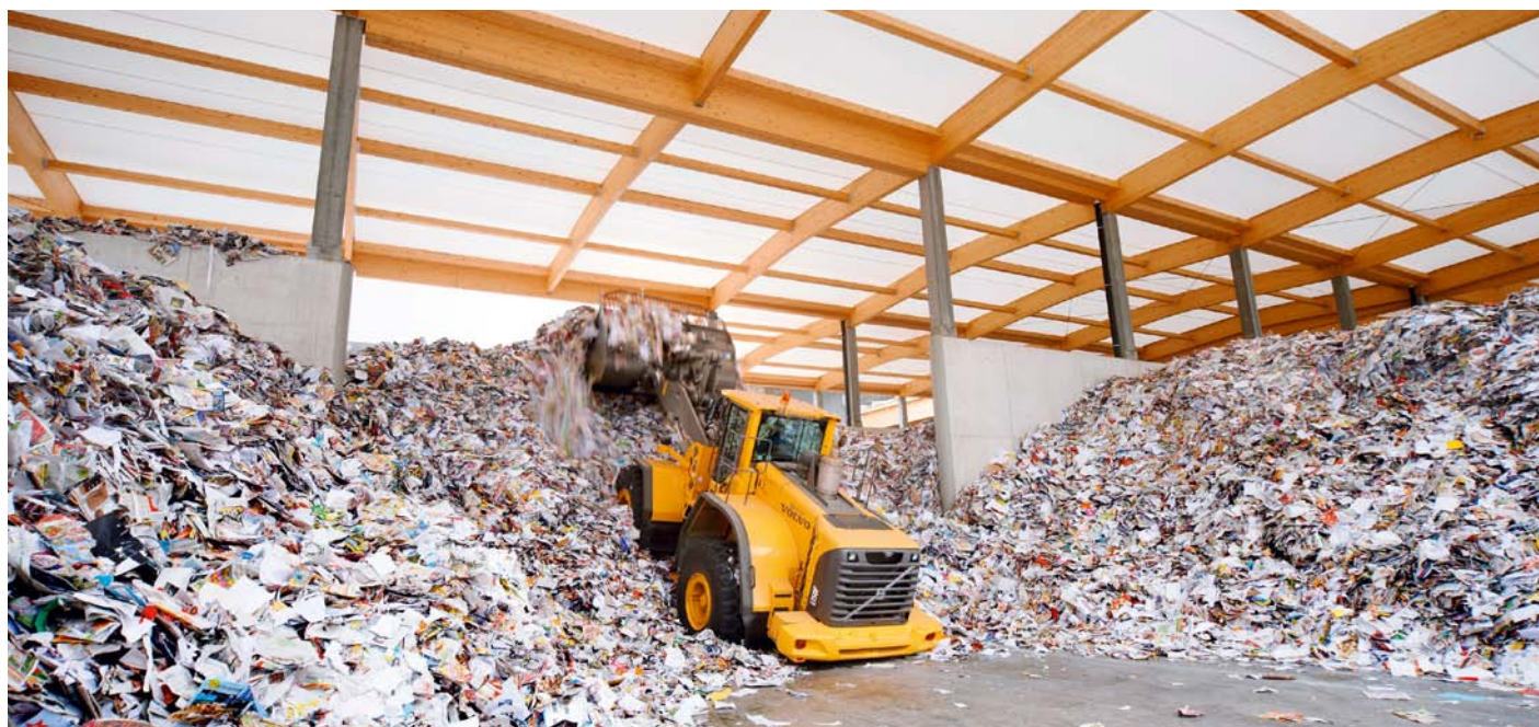
Neue Altpapier-Lagerhalle: Hier wird das angelieferte Altpapier zwischengelagert bis es anschliessend weiterverarbeitet wird.
